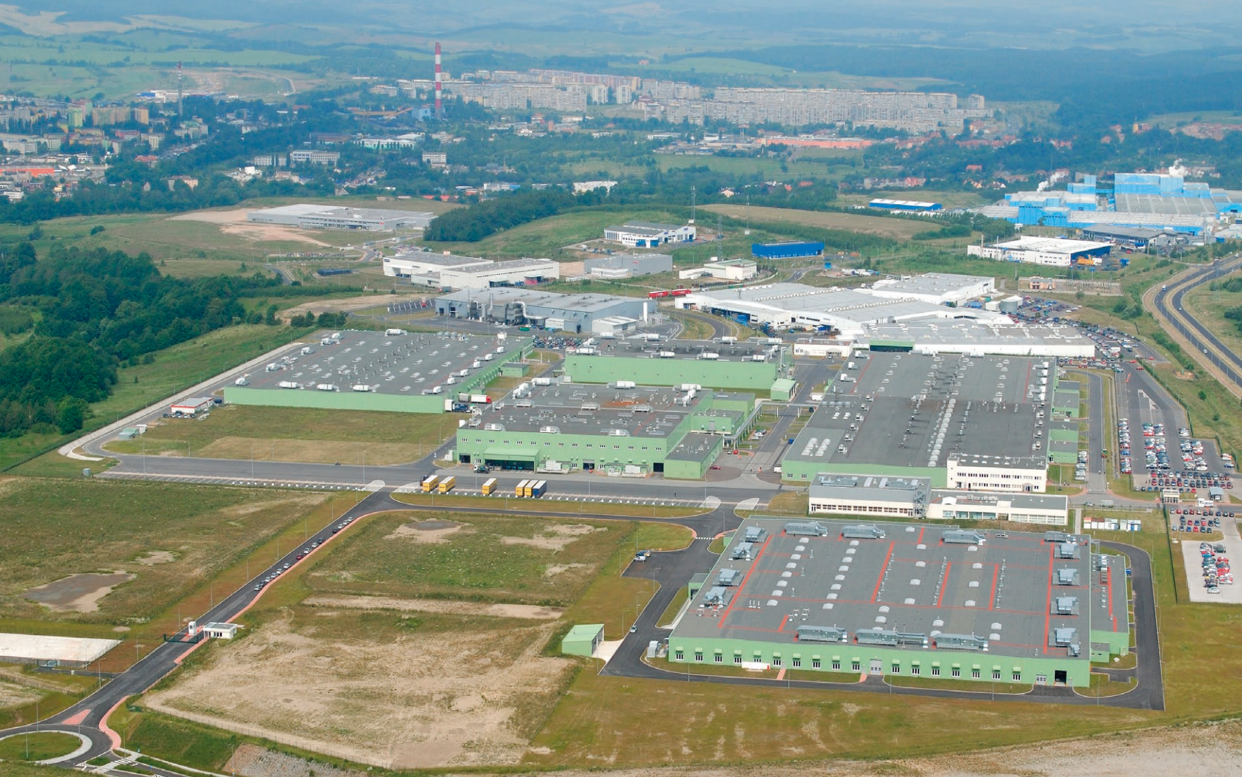
Gli investimenti nella ZSE „INVEST-PARK” di Wałbrzych, fin dagli anni 90, contribuiscono allo sviluppo sociale ed economico della regione. I gruppi Toyota, Faurecia, Cersanit vi hanno costruito i propri stabilimenti. Nella fotografia: aree della zona di Wałbrzych.
