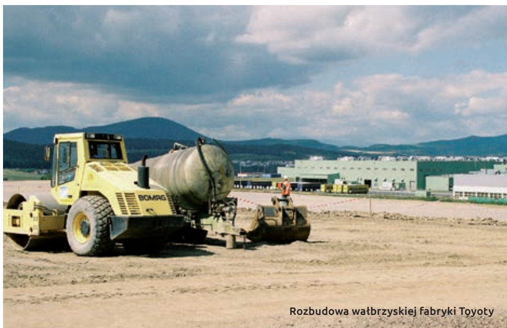
Budowa zakładu Toyota Motor Manufacturing Poland
