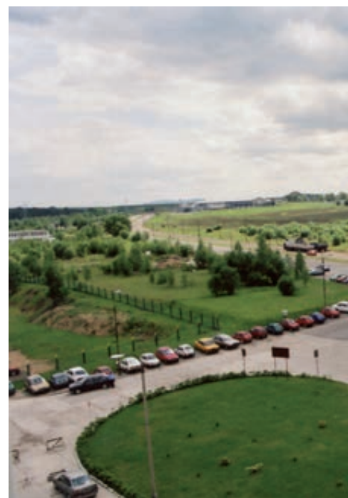
Budowa zakładu NSK Steering Systems
